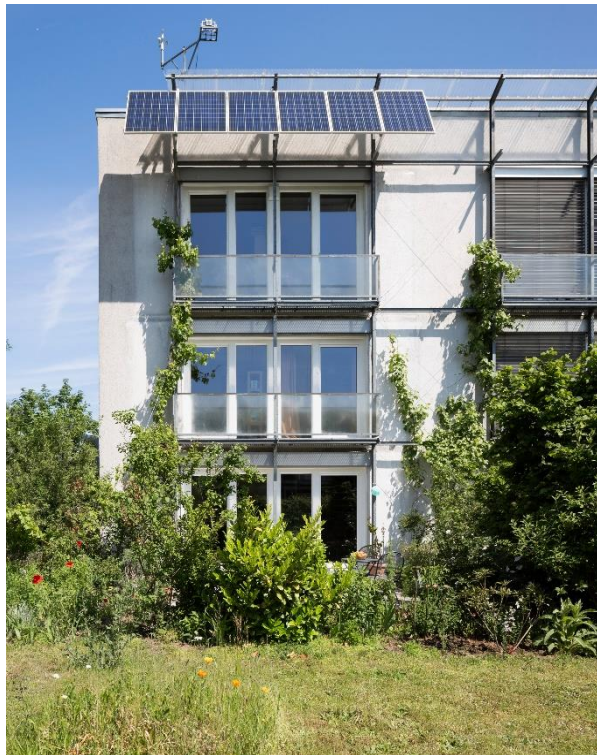
Das 1991 bezogene Pilotprojekt in Darmstadt erhielt nachträglich eine Photovoltaikanlage.
