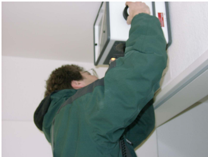
Abbildung 19: Messung des Zuluftvolumenstroms an einem Zuluftventil über der Wohnzimmertür
