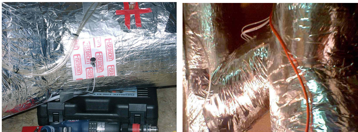
Abbildung 26: Ansaugen von Luftproben über Schlauchsystem (Zuluft-/ Abluftkanal)
