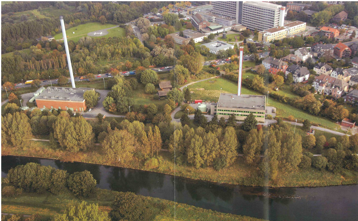
Abbildung 6: Baugrundstück an der Lippe mit Gebäudebestand (Quelle: npstv)
