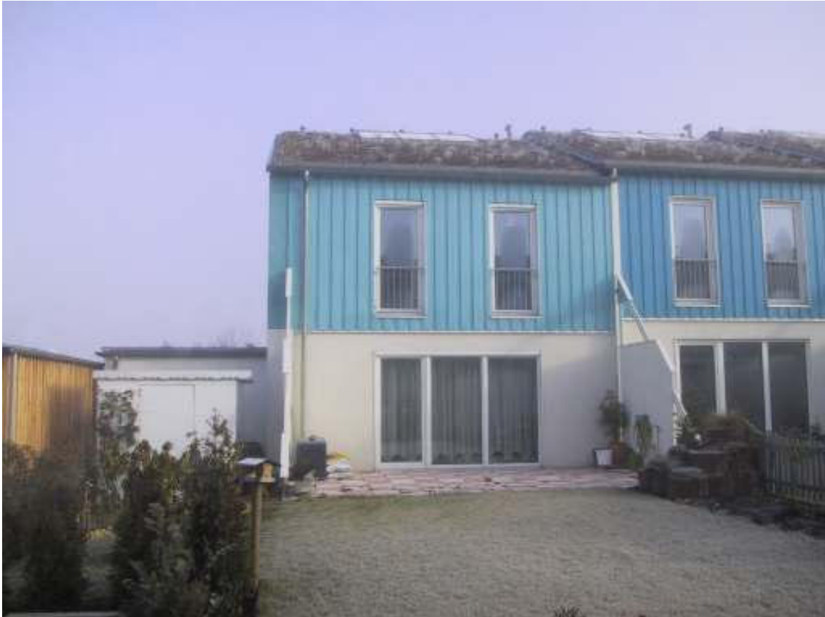
Abbildung 1: Blick von Süden auf das Haus 13.1. Die Terrassentrennwände links und rechts führen morgens und abends zu einer teilweisen Verschattung. Vor der westlichen Giebelwand steht das Technikhaus.
